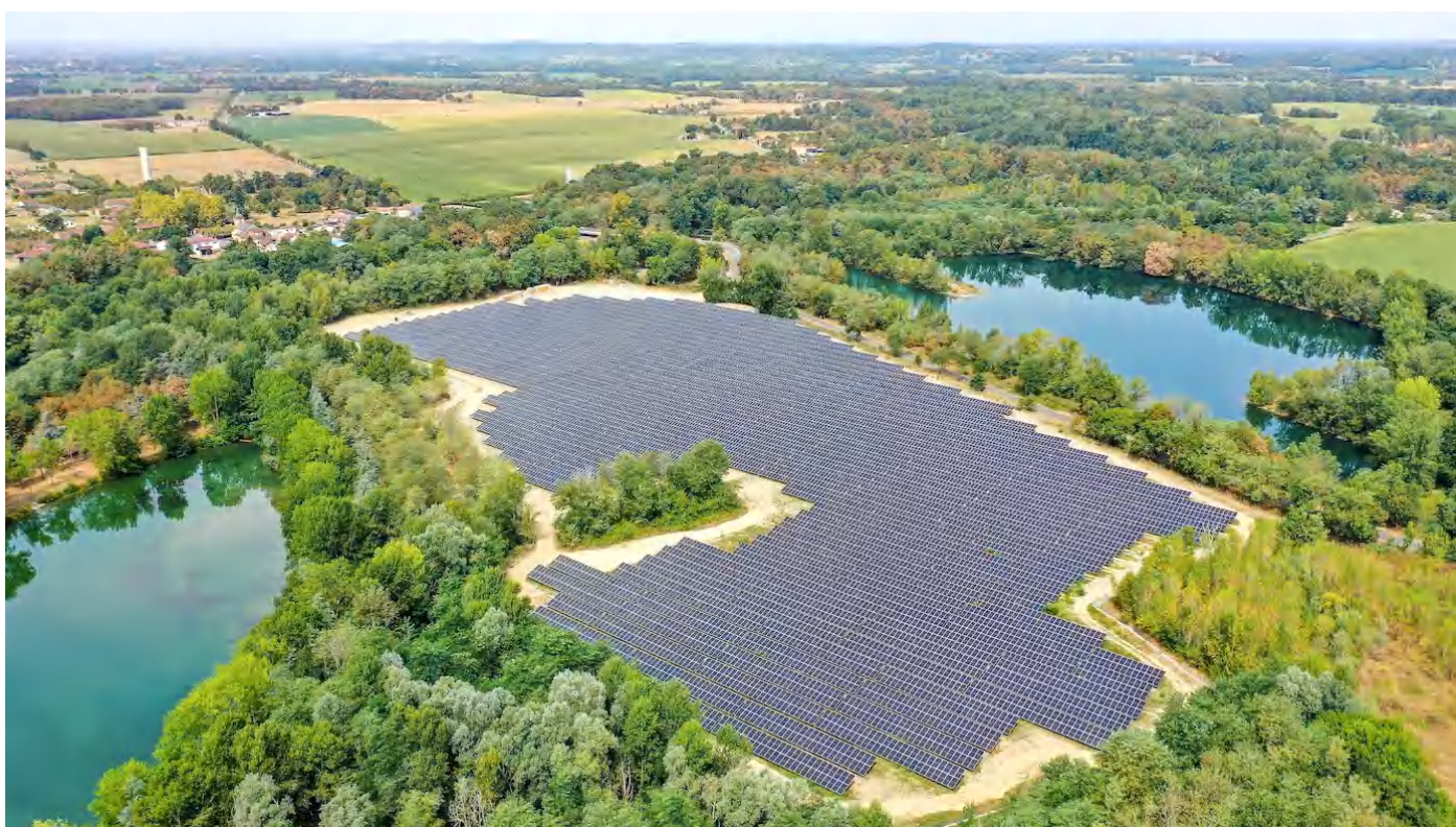
Figure 16: Parc solaire de Cahuzac-sur-Adour inauguré en novembre 2025 – Photo credit : Q Energy.
